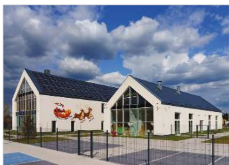
Węliniec Budowa budynku żłobka-przedszkola
