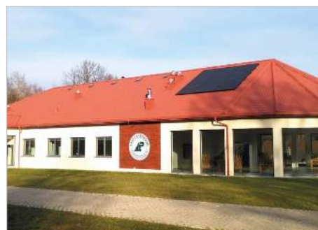
Koło Budowa Leśnego Ośrodka Rehabilitacji Zwierząt
