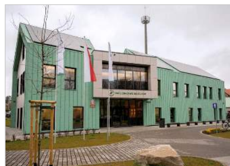
Sulechów Budowa budynku biurowego Nadleśnictwa Sulechów
