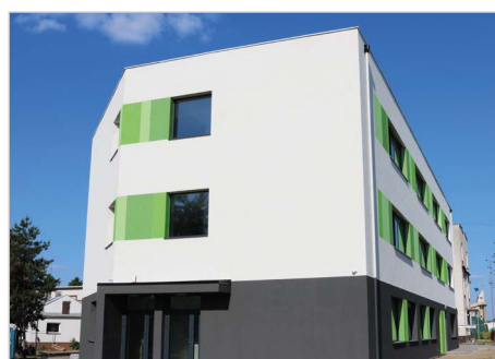
Wieruszów Pasywny budynek użyteczności publicznej przeznaczony na cele dydaktyczne Zespołu Szkół Ponadgimnazjalnych im. Stanisława Staszica i Poradni Psychologiczno-Pedagogicznej
