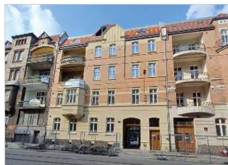
Katowice Remont budynku mieszkalnego przy ul. Gliwickiej 13
