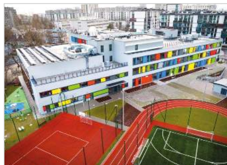
Warszawa Budowa zespołu szkolno-przedszkolnego ul. Anny German 5, 5a
