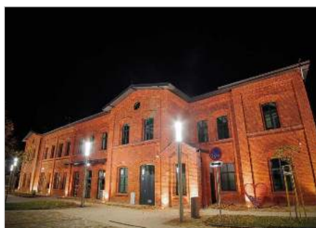
Żory Rewitalizacja dworca kolejowego i otaczającej go przestrzeni
