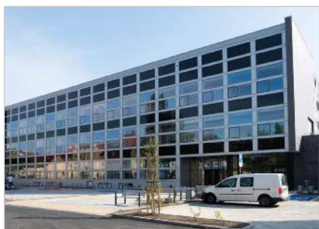
Zabrze Budowa Śląskiego Centrum Inżynierskiego Wspomagania Medycyny i Sportu „Assist Med Sport Silesia” wraz z Aulą wykładową
