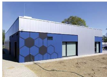
Drzewica Budowa budynku Miejsko Gminnego Klubu Sportowego "Drzewica"
