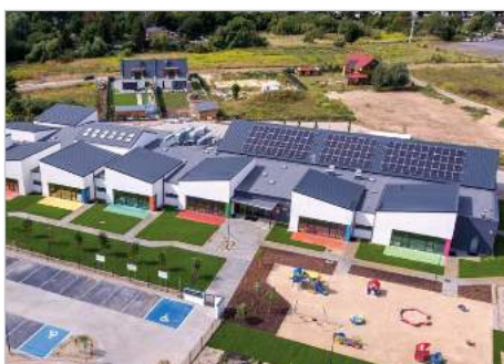
Kłodawa Budowa żłobka i przedszkola przy ulicy Wojcieszyckiej 7
