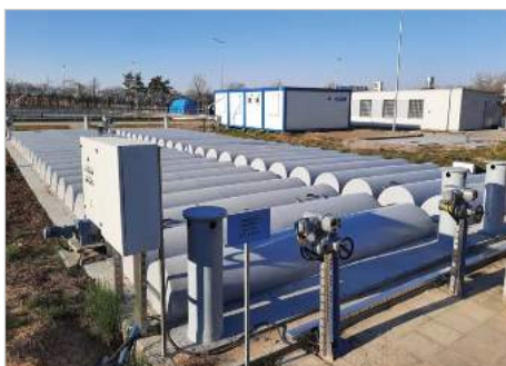
Jaroszewo gmina Żnin Modernizacja i przebudowa oczyszczalni ścieków
