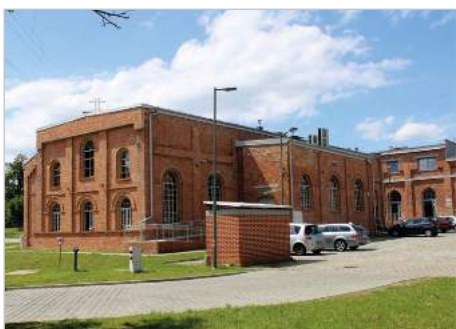
Rybnik Rewitalizacja budynku byłej sprężarkowni na terenie Zabytkowej Kopalni Ignacy
