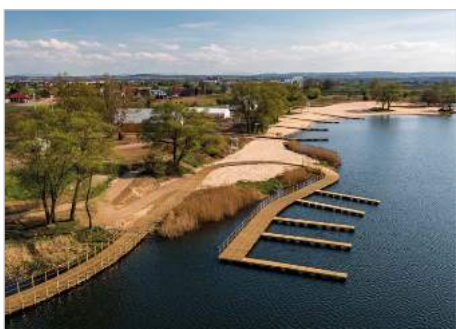
Kraków Budowa infrastruktury rekreacyjnej w otoczeniu zbiornika nr 1 w Przylasku Rusieckim
