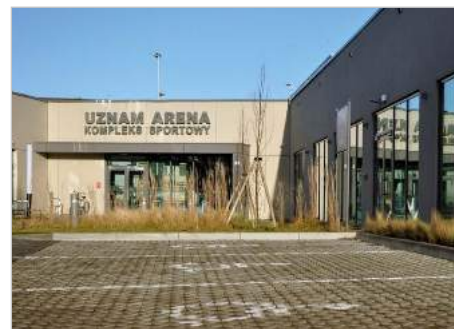
Świnoujście Kompleks sportowy "UZNAM Arena" i rozbudowa szkoły CEZiT
