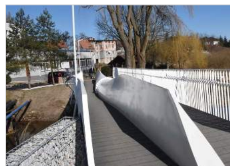
Szprotawa Pierwsza na świecie upcyklingowa kładka na łopacie turbiny wiatrowej
